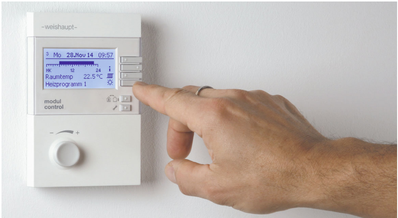
Über die Fernbedienstation WCM-FS wird die Heizungsanlage gesteuert
